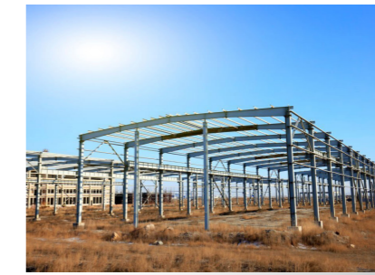
KHUNG KÈO 2 CỘT GIỮ MULTI-SPAN 2 BUILDINGS
