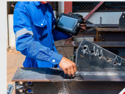
Kiểm Tra Mối Hàn | Welding inspection
