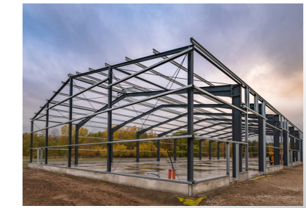
KHUNG KÈO 3 CỘT GIỮ MULTI-SPAN 3 BUILDINGS
