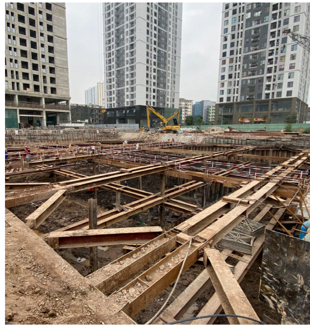
HỆ GIÀNG CHỐNG SHORING SYSTEM
