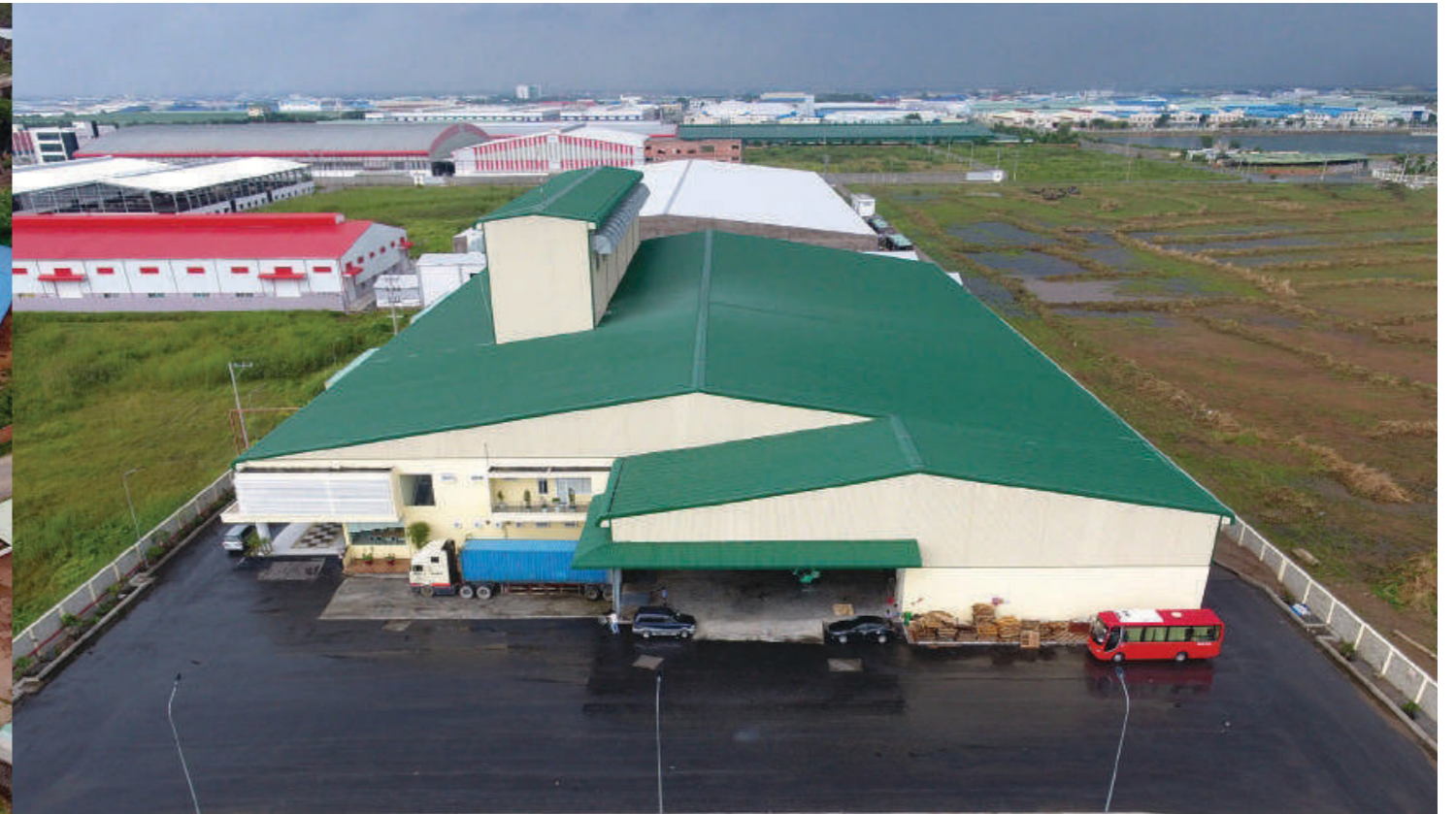
NHÀ XƯỞNG VINA FILM VINA FILM FACTORY
