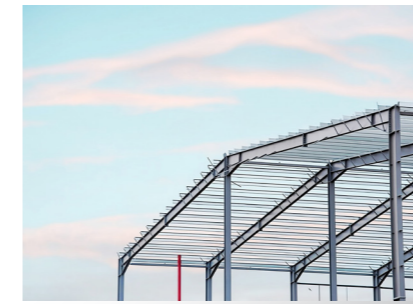
KHUNG KÈO 1 CỘT GIỮ MULTI-SPAN 1 BUILDINGS
